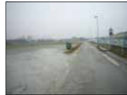
1 VISTA DA VIA SARACENI
